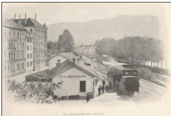
Das ursprüngliche (alte) Bahnhof.
