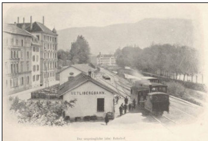
Das ursprüngliche (alte) Bahnhof.
