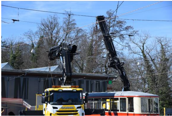
Die (ausgeschaltete) Fahrleitung erfordert von den Kranführern grösste Aufmerksamkeit
