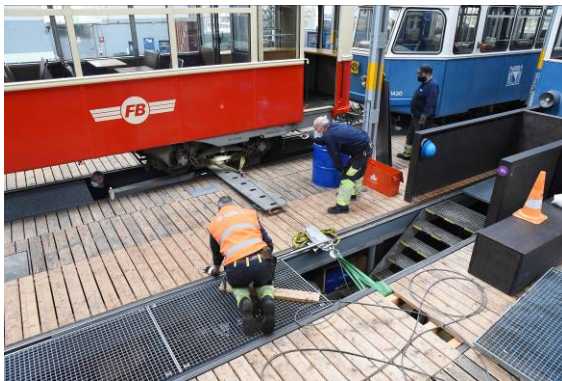
Millimetergenaues Positionieren des Wagens auf Gleis 3
